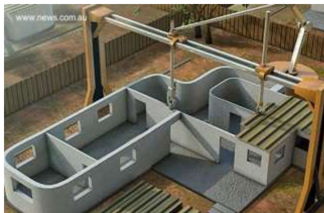
„Drukowanie domu” w 3D – skład masy to stabilizowanej, rozdrobnionej materiały z odzysku.
