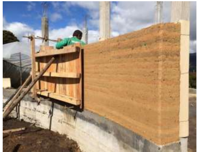
Ubijanie ziemi warstwami w szalunku pozwala osiągnąć niepowtarzalne efekty
